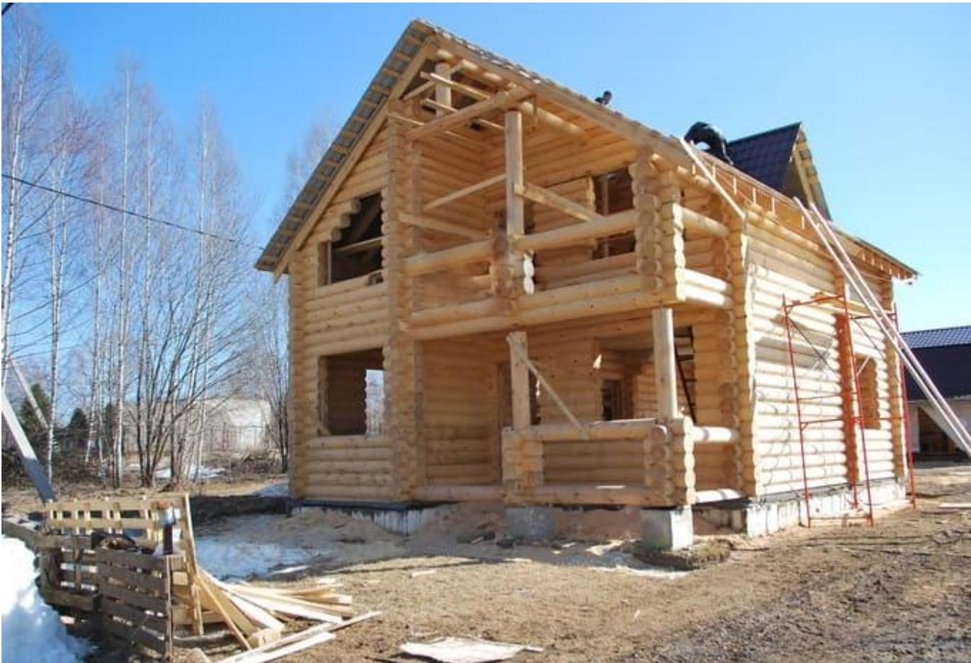
Также дополнительной мерой от деформаций является перевязка – это одно или два бревна, которые оставляют во всех оконных и дверных проемах. В верхней части вертикальных несущих опор (в зазорах) устанавливаются компенсаторы – металлические элементы, позволяющие производить регулировку высоты столбов.
