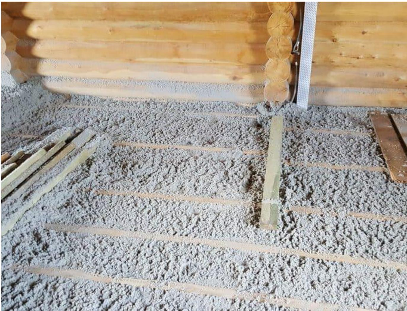
При утеплении дома эковатой потребуется уложить слой гидроизоляции и слой гидроветрозащиты. Таким образом будет защищен от влаги и сруб, и утеплитель.
